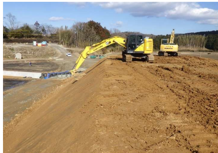
施工状況 (法面整形)
