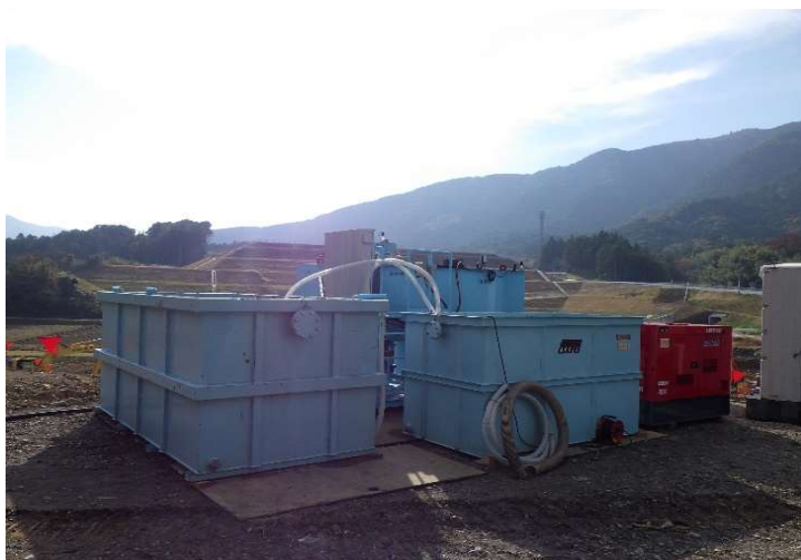
施工状況 (汚濁防止)
