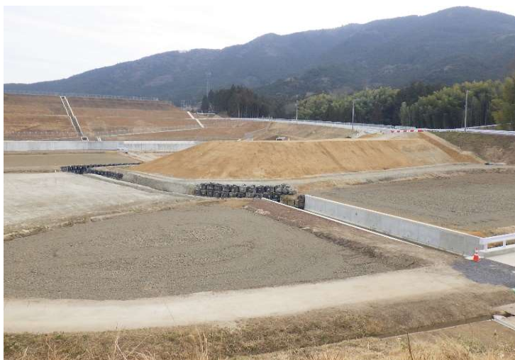
施工状況 (地盤改良)
