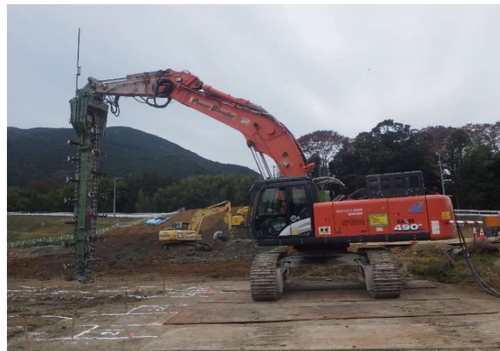
施工状況 (地盤改良)
